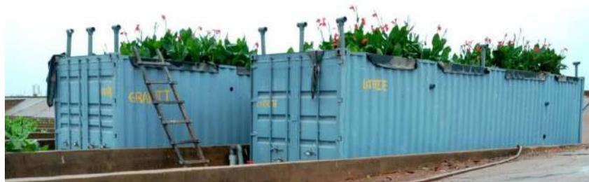
Photo 2: vue d'ensemble des pilotes des filtres plantés de *Canna generalis*
